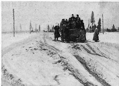
Рис. 7. В такое состояние приходит дорога зимой при отсутствии ухода
